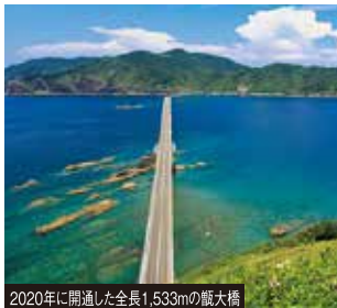
2020年に開通した全長1,533mの甌大橋
