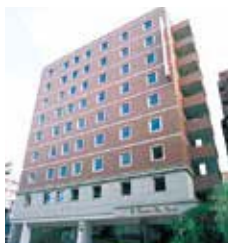
ツーリストイン高知(外観)
