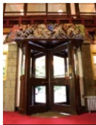
日光金谷ホテル 回廊扉
