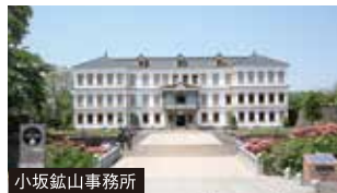
小坂鉱山事務所
