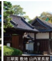
三翠園 敷地 山内家長屋
