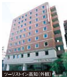
ツーリストイン高知(外観)
