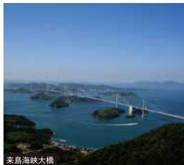
来島海峡大橋
